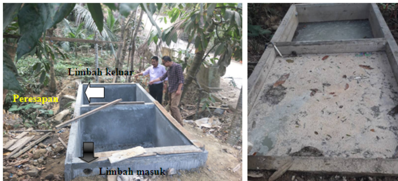
Gambar 36. Bak penanganan limbah growol.
